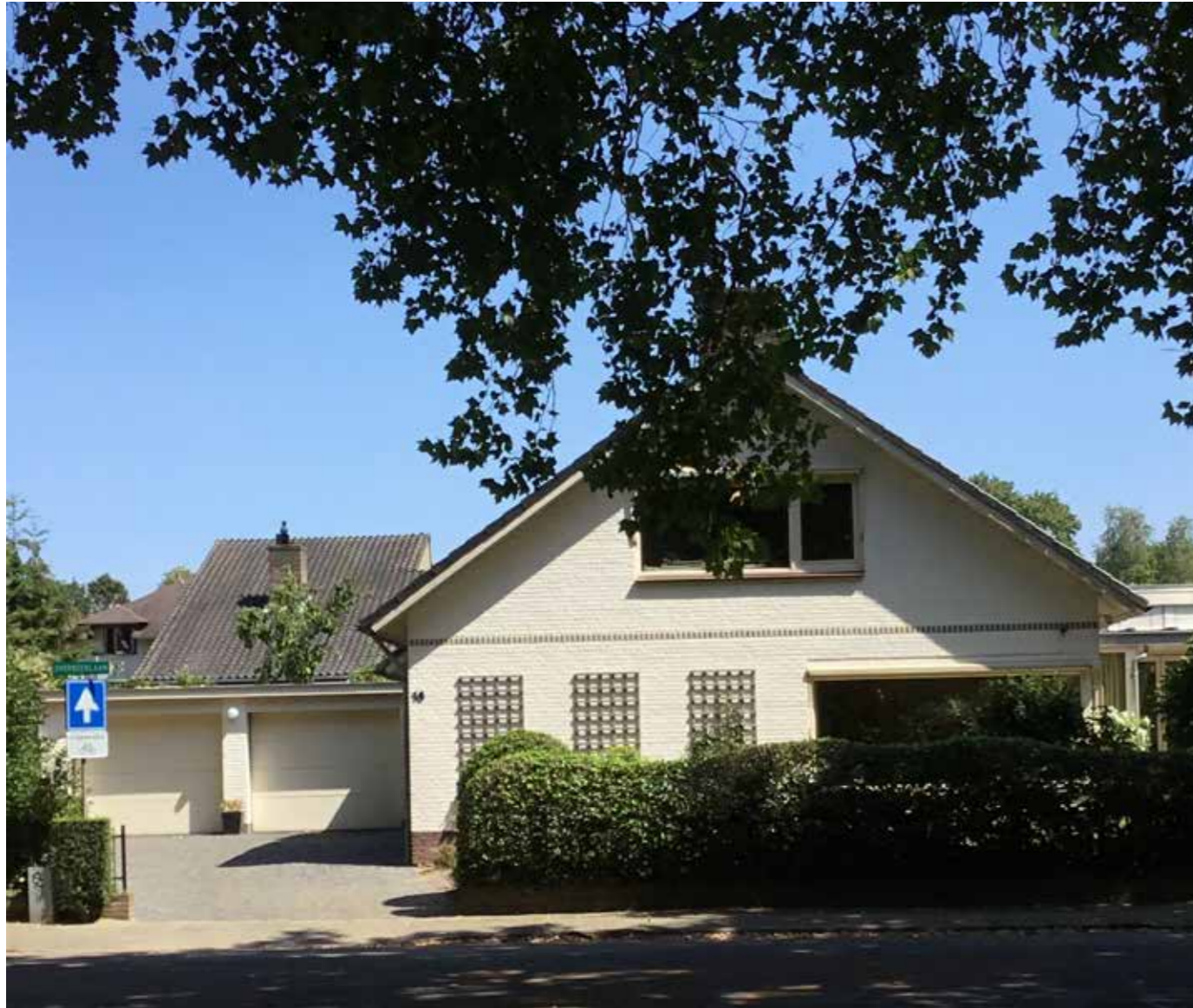
Bebouwing niet karakteristiek; Hier is meer mogelijk qua zonnepanelen.
