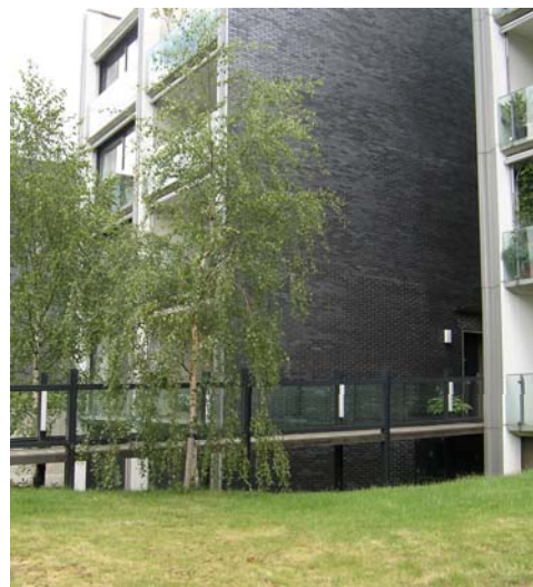
Hellingbaan vanuit de toegangsweg naar het dek
