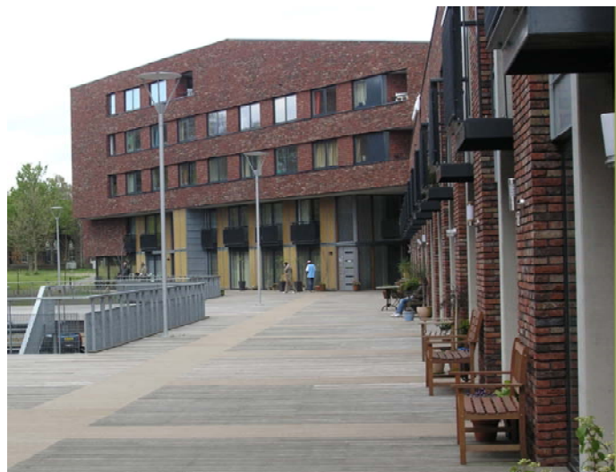
Oplopende hoogte, geknikte wand verzorgt beschutting, baksteenfamilie
