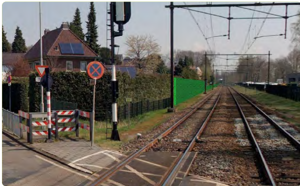
Voorstel ProRail op 27 juni '22: wisselende schermhoogte van 1, 1,5, 2 en 3m scherm dichtbij spoor
