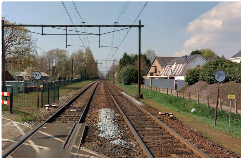
Huidige situatie vanaf Havelandseweg
