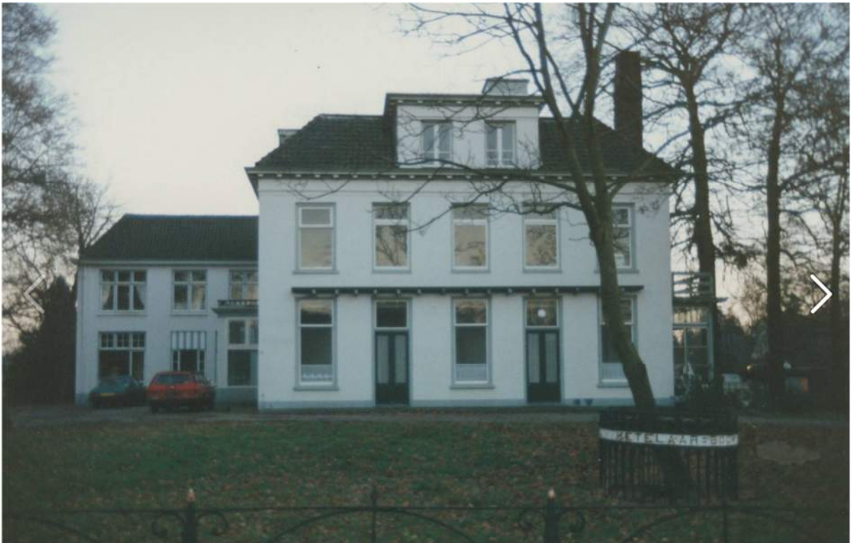
Het huis in zijn nadagen, met de Ketelaarboom aan de voorzijde.
