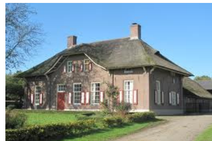
Restauratie monumentale bebouwing
