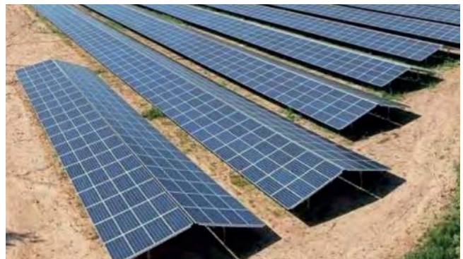
Oost-west georiënteerde panelen
