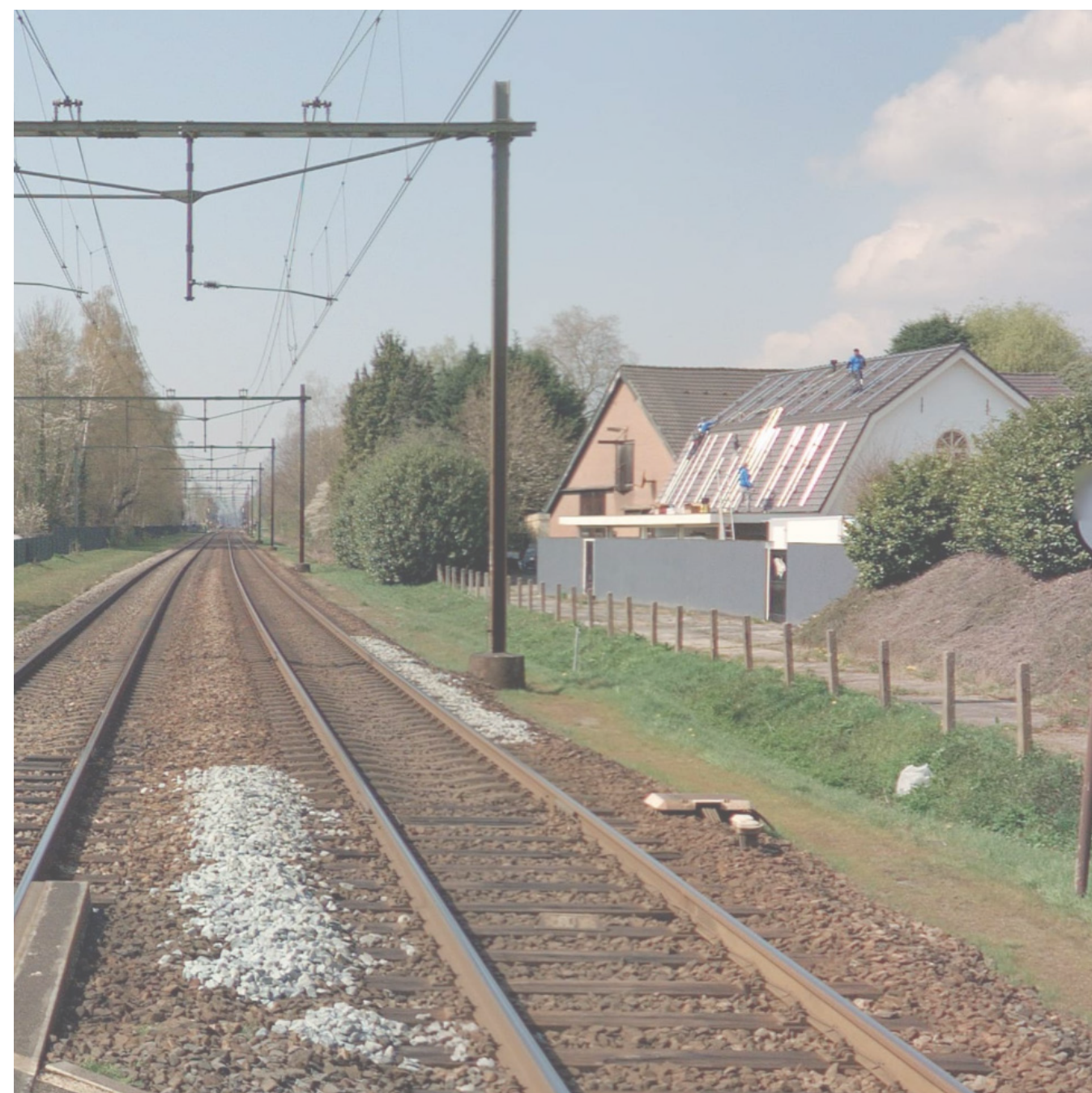
Huidige situatie vanaf Havelandseweg
