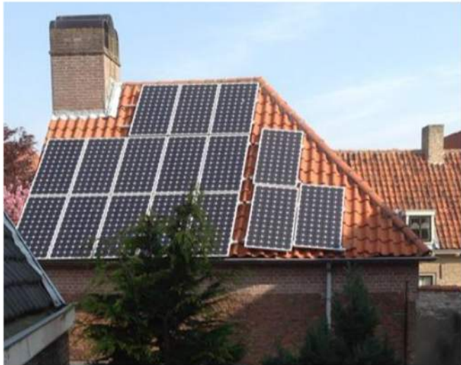
Panelen worden nogal eens in een grillige vorm op het dak gelegd rondom dakkapellen, dakramen en schoorstenen.
