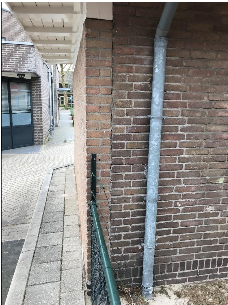
De aansluiting van de dichtgezette zijgevel van de zandbak op de achtergevel.
