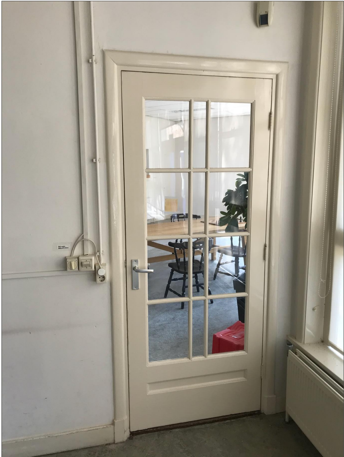
Eén van de deuren met een roedeverdeling tussen de lokalen. Originele deuropeningen in de school zijn herkenbaar aan de bolle omlijstingen.
