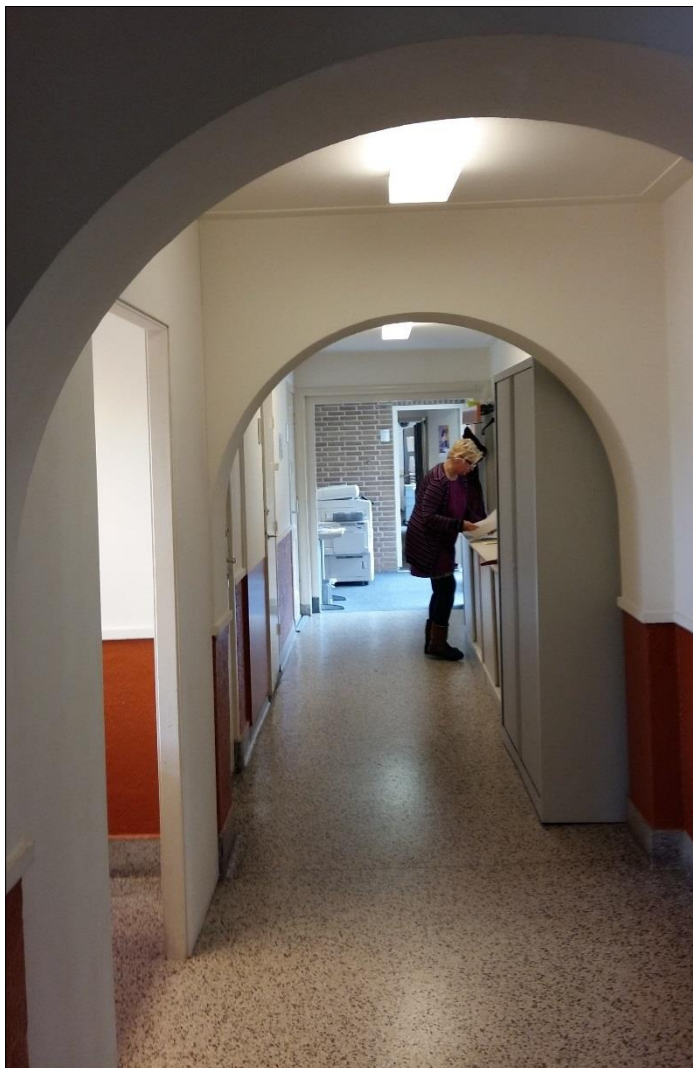
De granitovloer in de gang.
