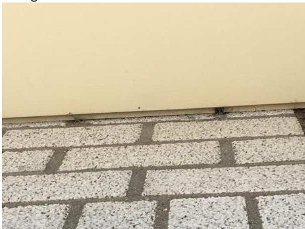
Detailaanzicht van de overstek; deze is zonder kieren aan de buitengevel bevestigd.
